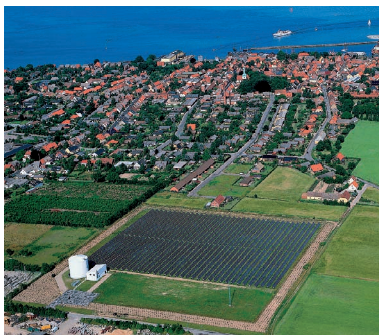
Abbildung 9 Luftbild der weltweit größten solarthermischen Anlage mit saisonalem Wärmespeicher in der Gemeinde Marstal auf der dänischen Insel Ærø
