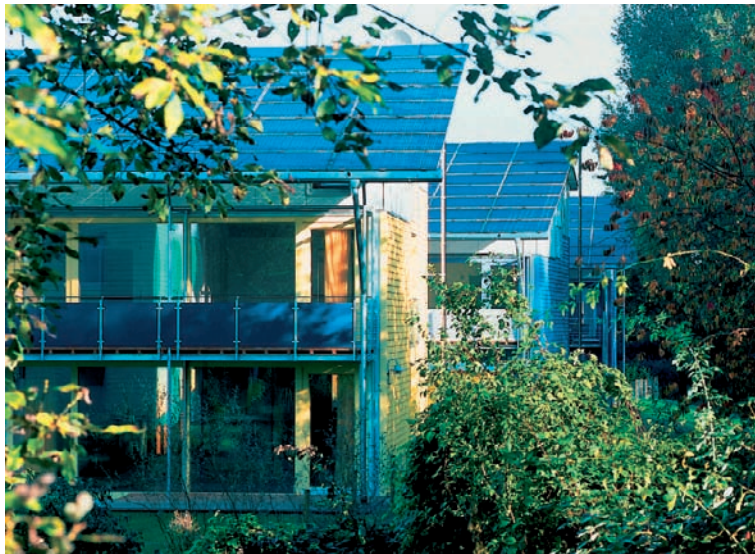
Abbildung 6 Photovoltaik-Anlage mit Dachfunktion: Solarsiedlung in Freiburg (Architekt Rolf Disch)
