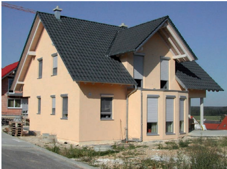
Abbildung 2 Neubau eines Einfamilienhaus in Burgberg (2007); Wärmedämmverbund- system mit VIP, Gesamtdämmstärke 9 cm, U = 0,14 \text{ W}/ (\text{m}^2\text{K})
