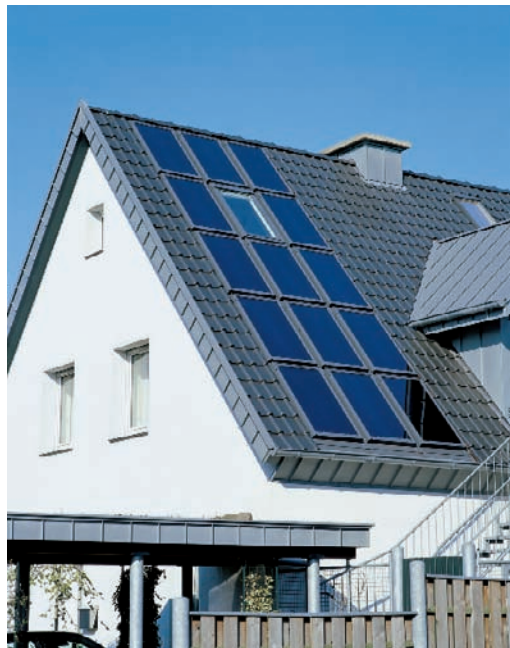
Abbildung 4 Dachintegrierte Solarthermie-Anlage. Eine Anlage dieser Größe deckt typischerweise mehr als 50 % des Warmwasserbedarfs und rund 20–30 % des Heizbedarfs eines Einfamilienhauses mit hohem Energiestandard
