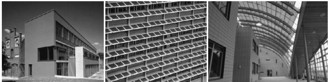
Abbildung 2 Das Zentrum für Umweltbewusstes Bauen in Kassel (links), PV-Fassade des ECN Gebäudes 31 (Mitte) und Wintergarten mit PV des ECN Gebäudes 42 (rechts)
