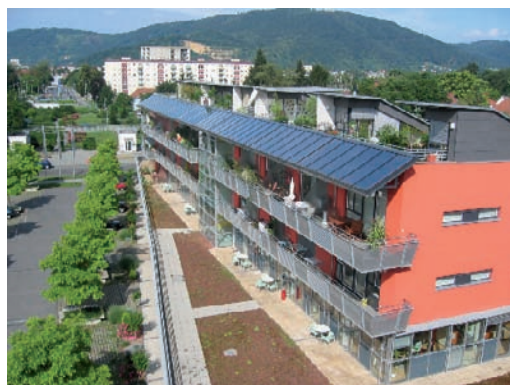
Abbildung 5 Solarthermische Anlage für ein Mehrfamilienhaus in Graz. Der Markt für die Nutzung der Solarthermie in Mehrfamilienhäusern ist noch wenig entwickelt.
