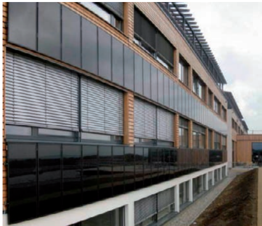
Abbildung 4 Die Südwand der Juwi- Unternehmenszentrale mit 184 Modulen hat eine Leistung von 10 KW
