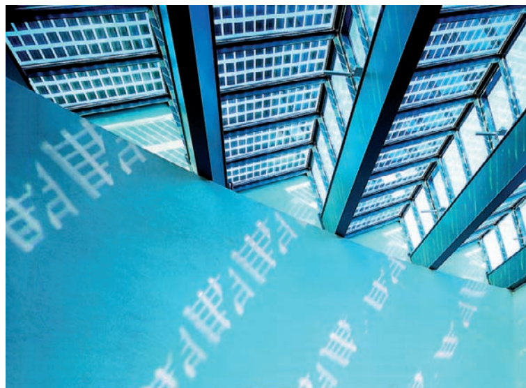
Abbildung 8 Glasintegrierte Photovoltaik-Zellen, die zugleich eine erwünschte Verschattung bewirken am Fraunhofer-ISE in Freiburg
