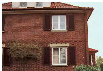
Abb. 8: Backsteinfassade mit sichtbarem Fenstersturz aus Beton
