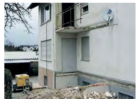
Abb. 55: Abbruch von Stahlbetonplatten zur Wärmebrückenvermeidung
