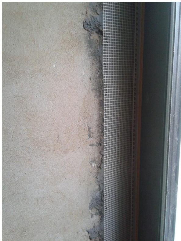
Anschluss außen mit Armierung Aufnahmedatum:22.3.2019
