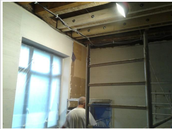
Innendämmung im Anbau Aufnahmedatum: 12.4.2019
