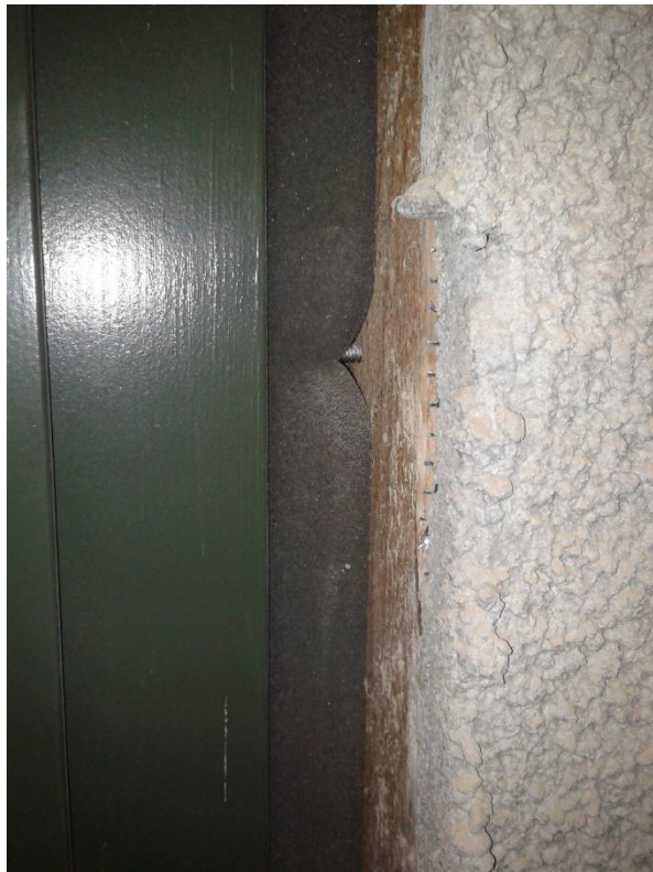
gequetschtes Kompriband mit Lücken Aufnahmedatum:22.3.2019
