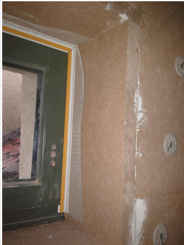
guter Anschluss mit APutz, Armierung, Laibungsplatte Aufnahmedatum:22.3.2019
